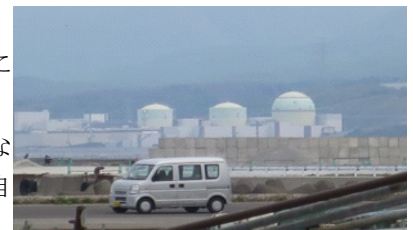
恵内村の隣村に建設された 泊原発
