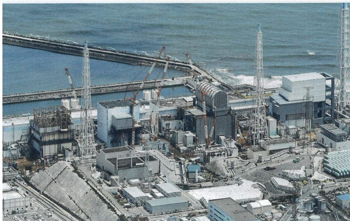
廃炉中の福島第1原発(4基)
