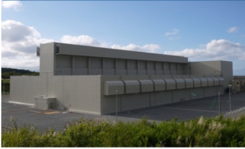
リサイクル燃料貯蔵センター（提供：リサイクル燃料貯蔵株式会社）
