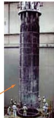
伝熱管束 (据付時写真) 蒸発器140本/基 過熱器147本/基
