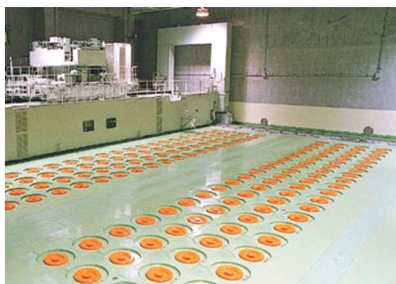
ガラス固化体を収納する収納管(日本原燃HPより)
