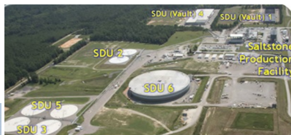
図2 サバンナリバー核施設における コンクリートタンク建設現場
