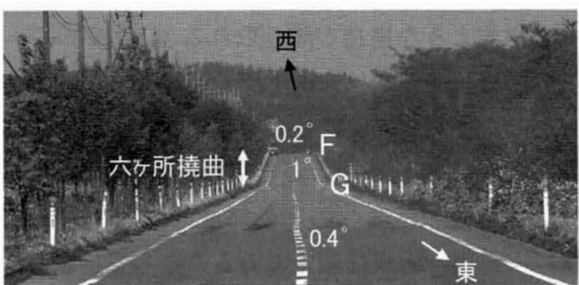
図 6—鷹架沼南岸の M1 面の変形
