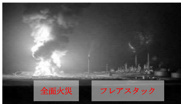
図2 浮き屋根式タンクの全面火災(1983年8月30日、アモコ製油所)
